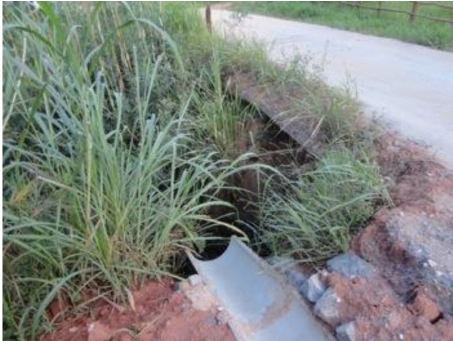
Figura 33- Drenagem ao lado da cabeceira da Ponte, apresentando pontos com erosão, necessitando de reparos.
